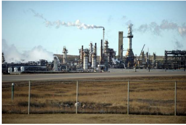
Exploitation pétrolière de la compagnie canadienne Syncrude à Fort McMurray, dans les sables bitumineux de la province d'Alberta, le 1er avril 2015 ( AFP / Clement Sabourin )
